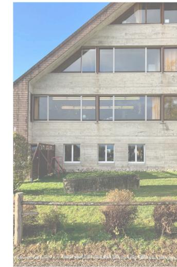
L'annexe Ouest est revêtue d'un complexe isolé avec revêtement bois, sa matérialisation et sa nouvelle toiture flanquée d'un couvert solaire l'intègre formellement aux couverts et nouvelles annexes du préau et des accès.
