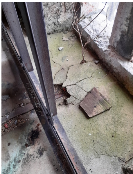
Corrosion et fissures de la dalle sous les cloches
