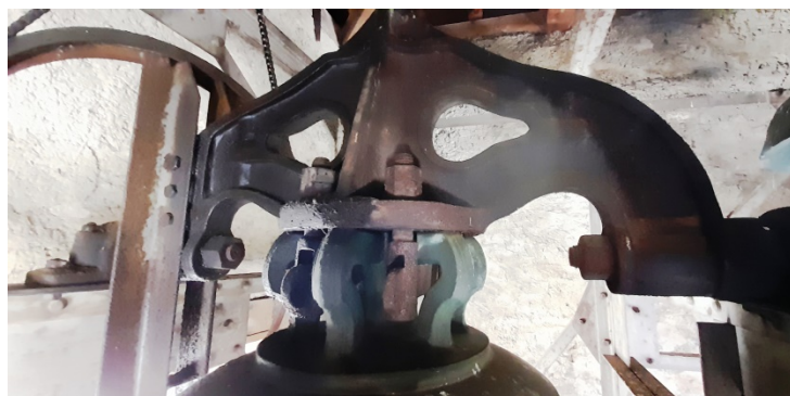
Corrosion des éléments de suspension (installés en 1914-15 après l'incendie de 1913)
