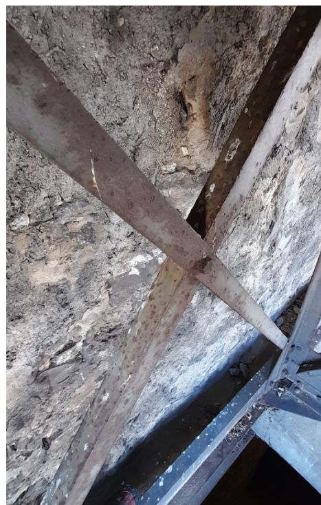
Corrosion des éléments de suspension (installés en 1914-15 après l'incendie de 1913)
